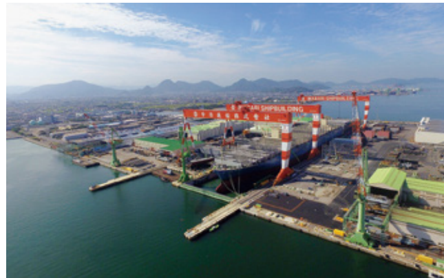
今治造船 丸亀新ドック（当社施工）
