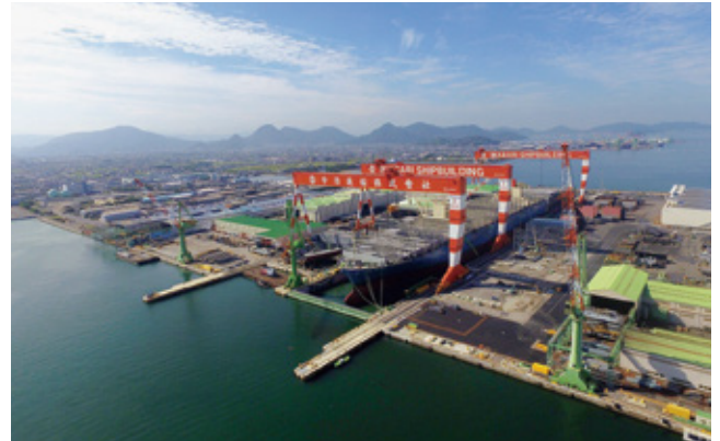
今治造船 丸亀新ドック（当社施工）
