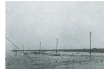
現東京羽田空港第1期敷地造成工事 (大正15(1926)年着工)
