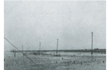
現東京羽田空港第1期敷地造成工事 (大正15(1926)年着工)
