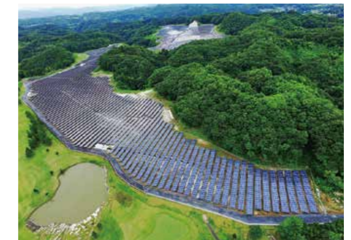
【実績】SGET常陸大宮メガソーラー発電所建設工事
